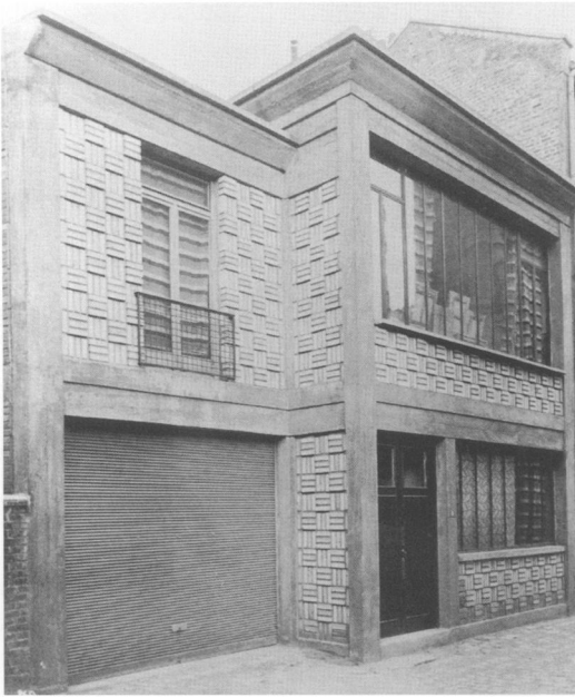
Fig. 8. Perret: house for Mela Muter (Photo: Chevojon. Institut Français d'Architecture, Archives d'architecture du XXe siècle)
